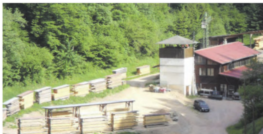
Die Zimmerei mit Abbundhalle, Sägewerk, Sägemehlsilo im Scherlenzendorf
